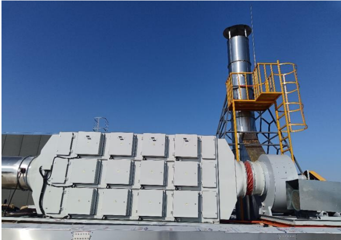
慈溪新能源汽车零部件产业基地五金车间油雾集中处理系统
